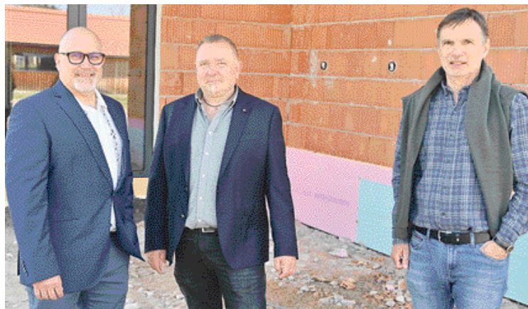
Noch vor wenigen Wochen stan-den Vzbgm. Harald Reiterer, Vorstandsmitglied Johann Pirker und Bgm. Karlheinz Schuster vor einem Rohbau. Jetzt ist das moderne Sanitärgebäude kurz vor der Fertigstellung.
