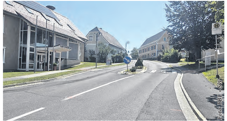
In Wettmannstätten wird die Ortsdurchfahrt neu gemacht. Der Abschluss der Arbeiten ist für November geplant.
