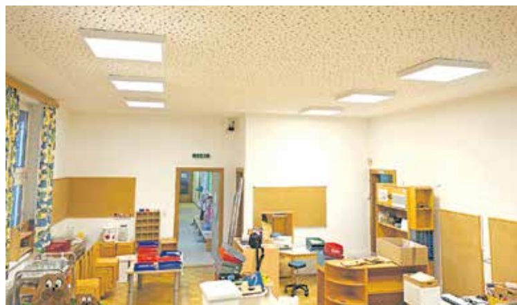
Akustikdecke und LED-Beleuchtung machen das Spielen und Arbeiten im Kindergarten für Kinder und Betreuungsteam noch angenehmer.
