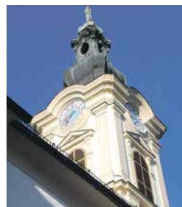
In einem weiteren Sanierungsschritt wird 2022 der obere Teil des Turmhelms erneuert, an dem der Zahn der Zeit kräftig nagt.
